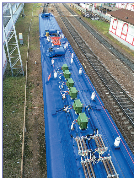
Рис. 2. Комплект сглаживающих реакторов, установленных на крыше электропоезда
