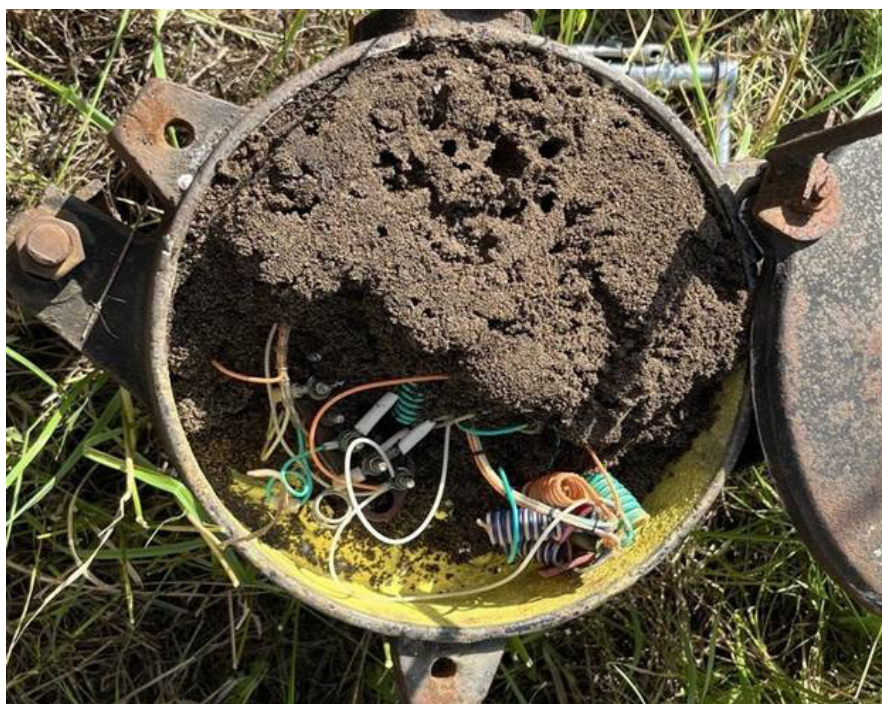
Рисунок 1 – Муравейник в разветвительной муфте
