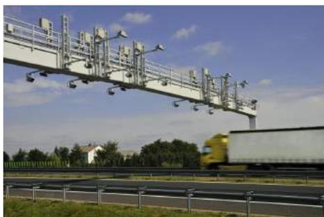
Рис. 1. Дорожная опора с датчиками для связи с устройством viaToll [12]
